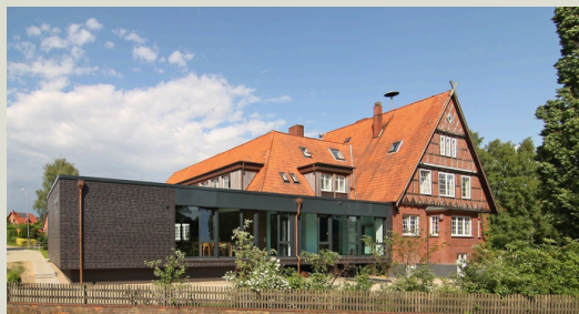
Neues Tagungszentrum (an die ehemalige Grundschule angebaut)
